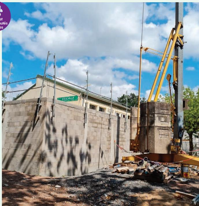
Pour mener à bien ce projet un **réaménagement du bâtiment est en cours**. Des travaux de désamiantage de l'ensemble de l'Escale ont d'abord été réalisés. Une **extension de 125m<sup>2</sup> est en construction sur l'avant du bâtiment ainsi qu'une terrasse**. Le bâtiment sera entièrement isolé, les anciennes fenêtres en simple vitrage remplacées.
